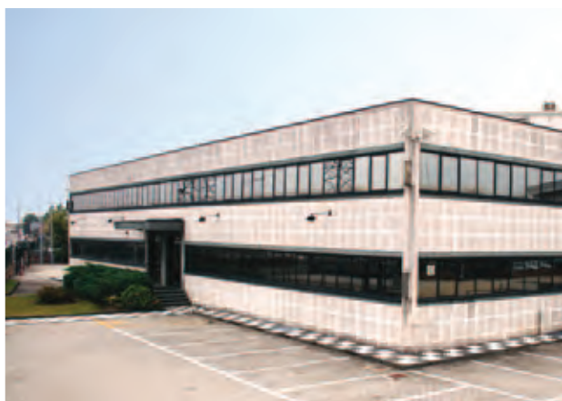
Sede La Filometallica San Giuliano Milanese (MI)
